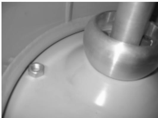
图 5-5 地电位接触不良
